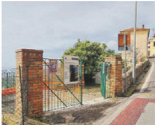
I lavori in corso nella scuola di Maranola
